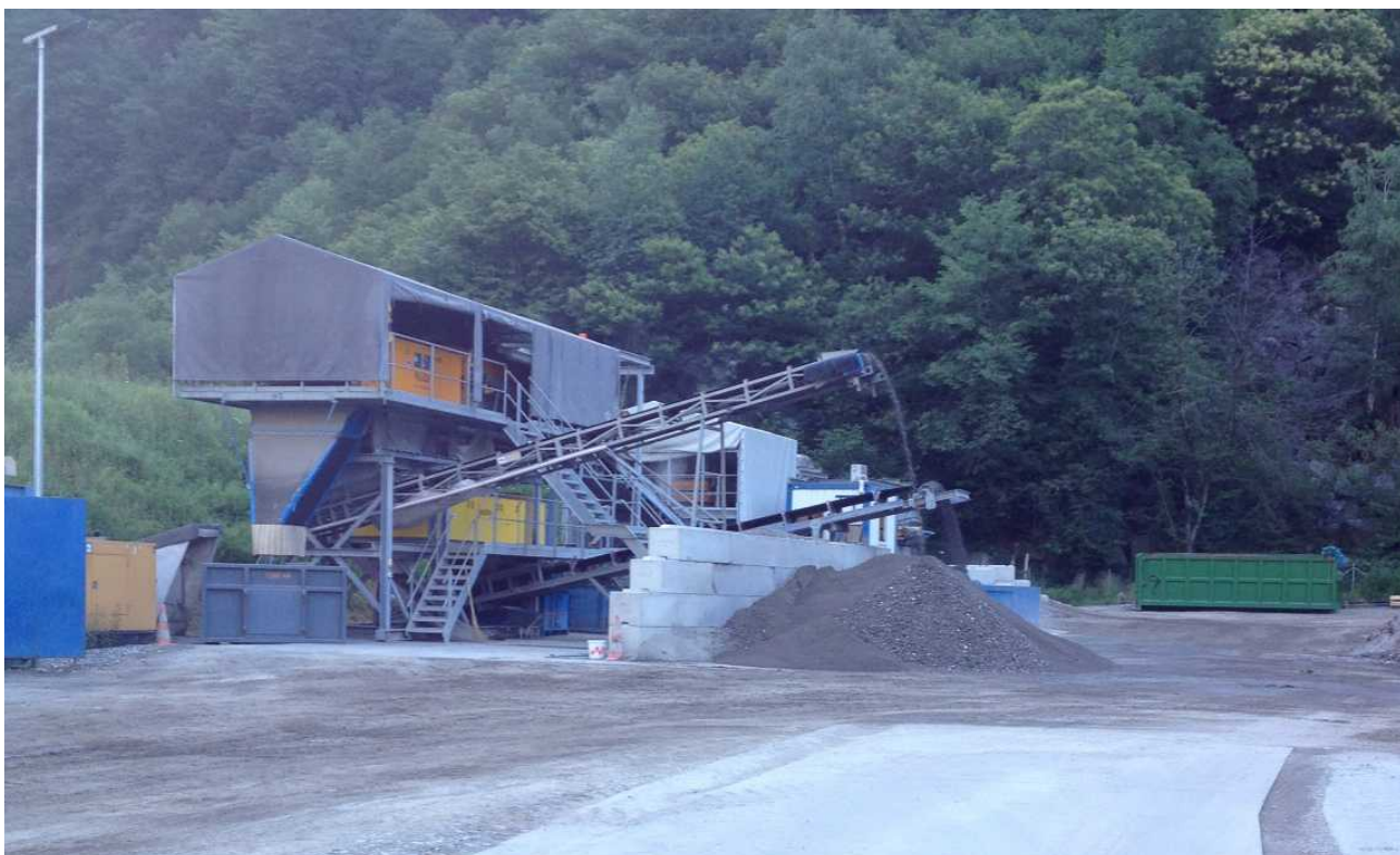
Figura 4 Impianto di vagliatura.
