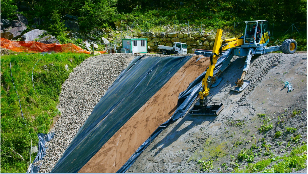
Installazione della miscela Trisoplast in discarica, compattata per uno spessore di 20 cm tra teli geotessili e ricoperta da uno strato drenante di materiale ghiaioso dello spessore di 40 cm
